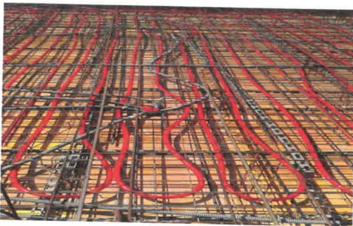
Foto von Leitungsverlegung aus der Herstellphase
