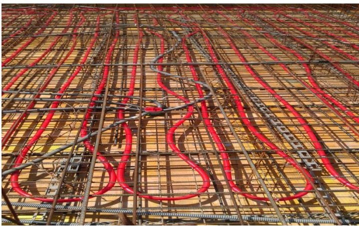
Foto von Leitungsverlegung aus der Herstellphase
